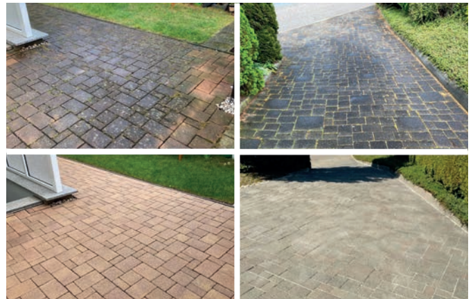
Zwei Steinflächen jeweils vor (oben) und nach der Sanierung (unten). (Fotos: MH Stone – Steinpflege Härtel)
